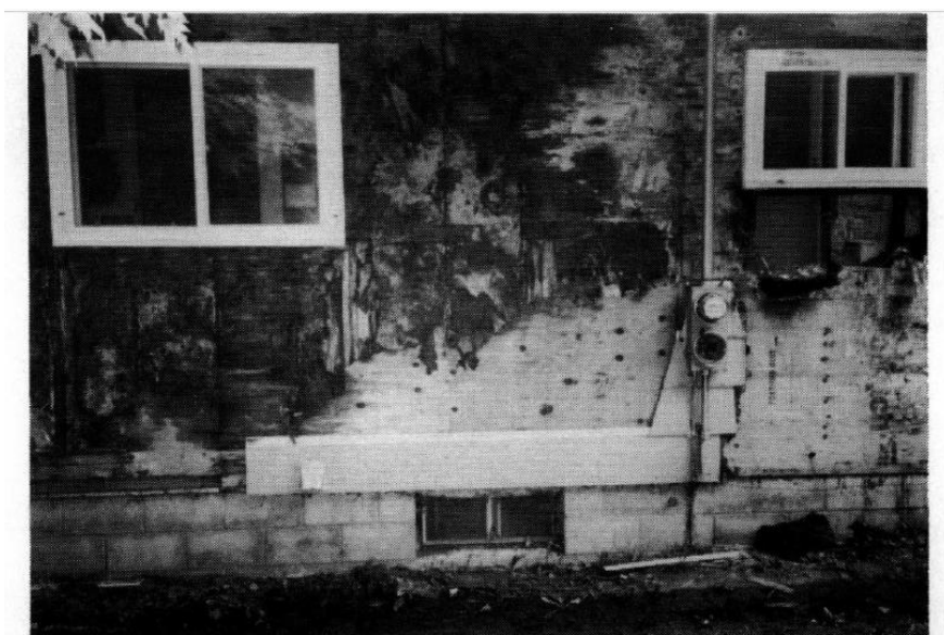
Figure 21 : Exemple de dommages dus à la condensation. Source : TenWolde et Rose
