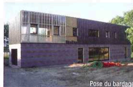
Pose du bardage.
