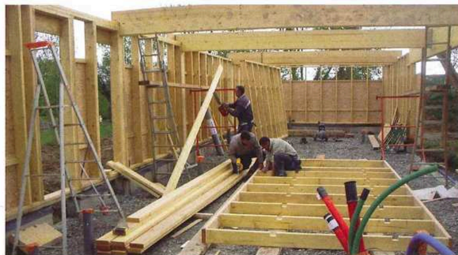
Montage de la structure bois. L'entreprise du lot bois est la SARL Fougères de Bourgneuf-la-Forêt. Le hérisson de graviers est ceinturé par des blocs de béton. La dalle sera coulée dans un second temps.
