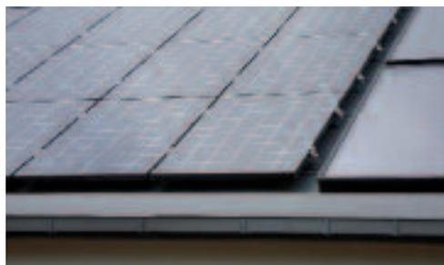
Les systèmes dont les modules ne sont pas solidaires entre eux et où l'étanchéité est assurée par l'installation d'une sous-couche de type bac acier ou PEHD (polyéthylène haute densité) sont éligible à une prime d'intégration dite simplifiée.
