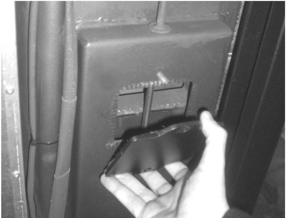
Après avoir dévissé les deux boulons, retirez la plaque d'inspection du passage de fumées latéral (côté pellet).
