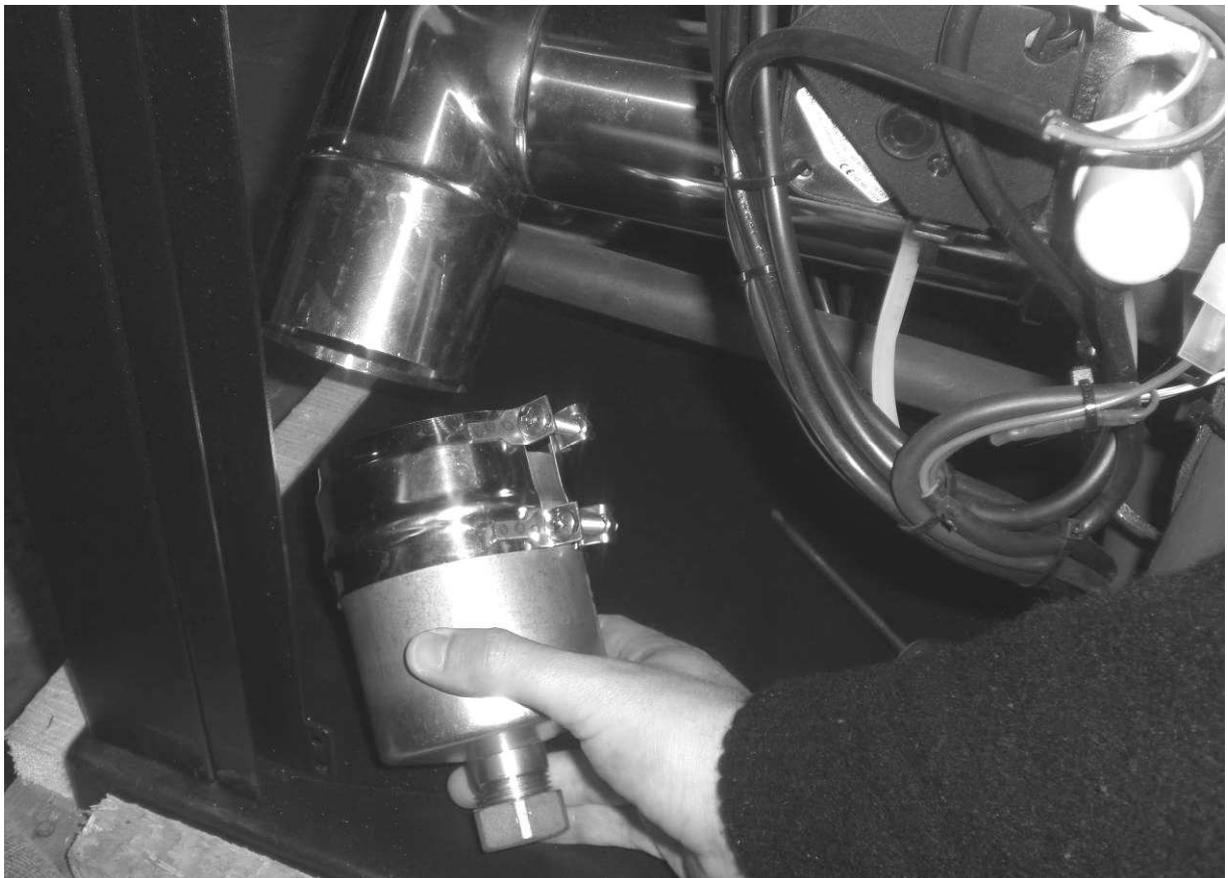
Retirez le bouchon d'inspection du té en acier inox.
