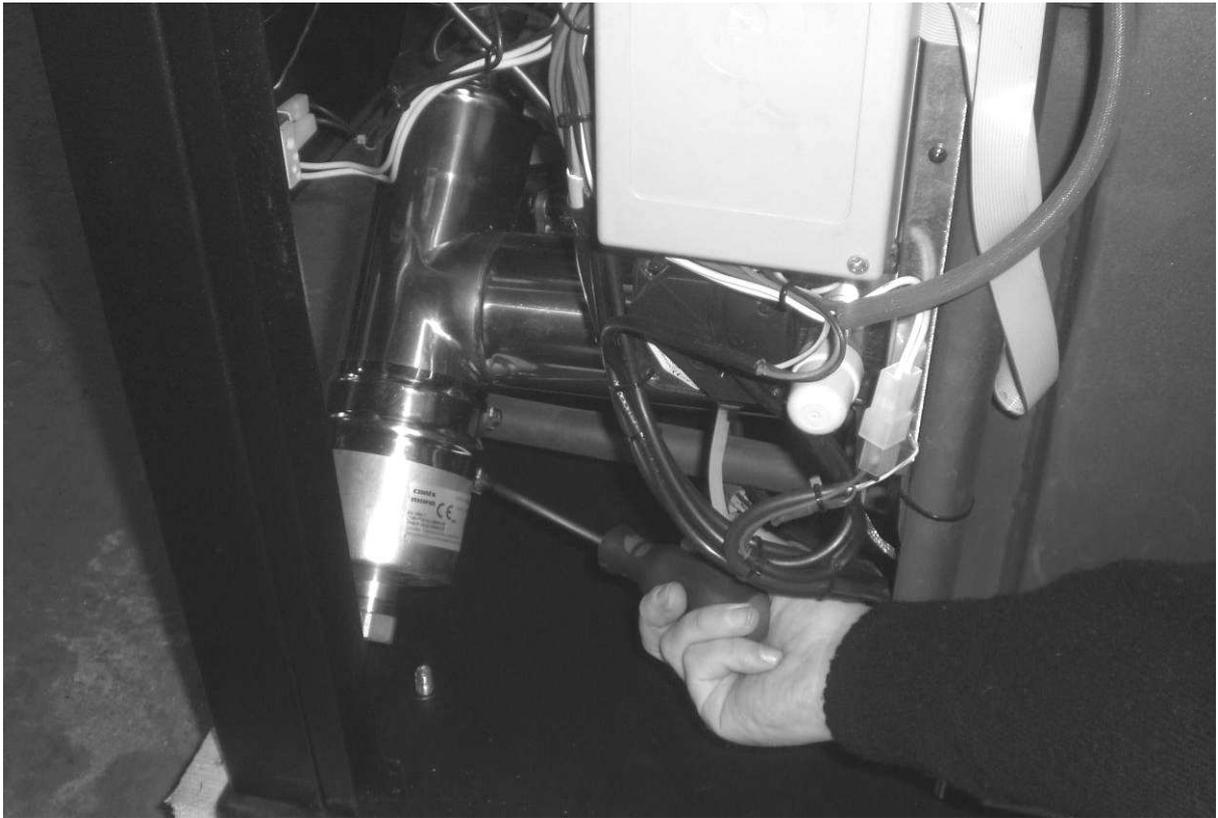
Dévissez les deux vis du collier qui fixe le bouchon d'inspection du té en acier inox.
