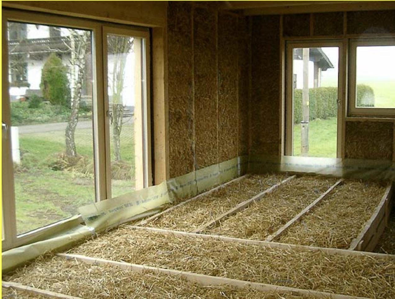
Possibilité d'isolation du plancher en remplissage paille
