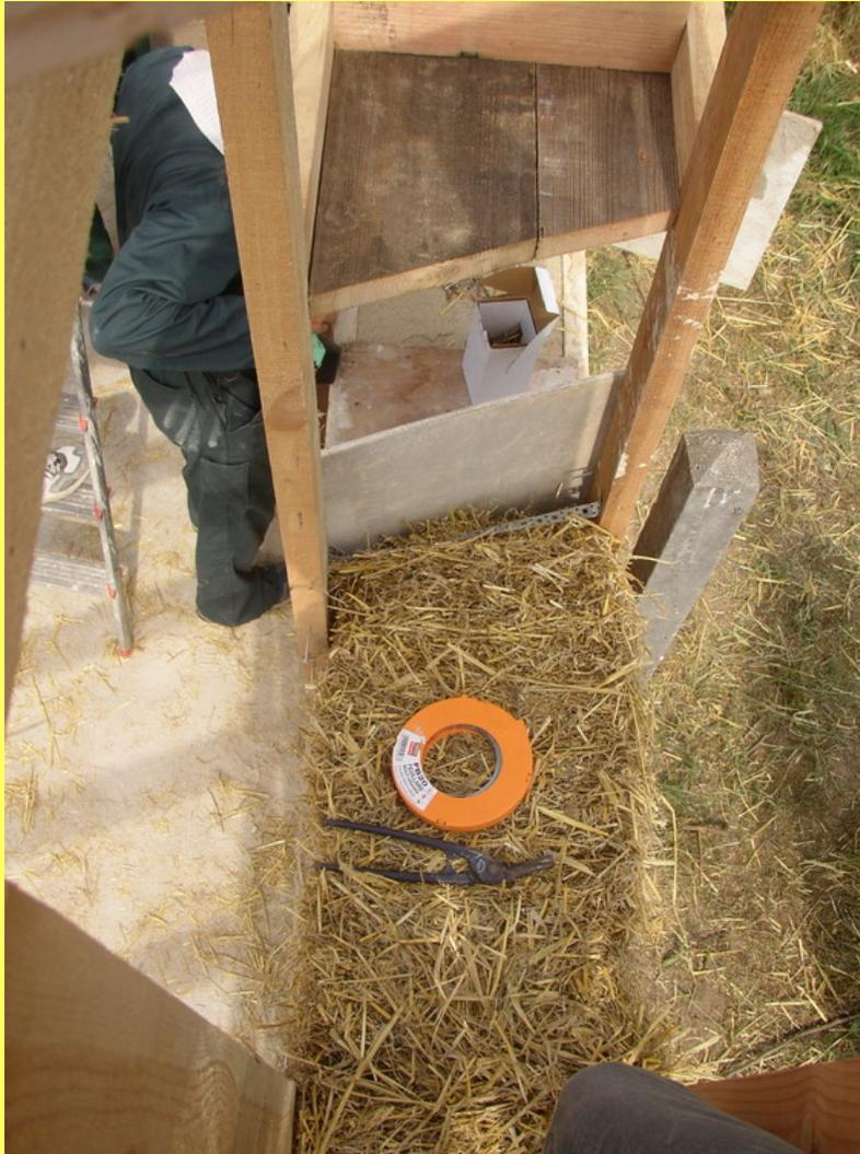
Technique dite du « GREB » à double ossature bois, enduits par coffrage intérieur / extérieur, protection possible par bardage bois
