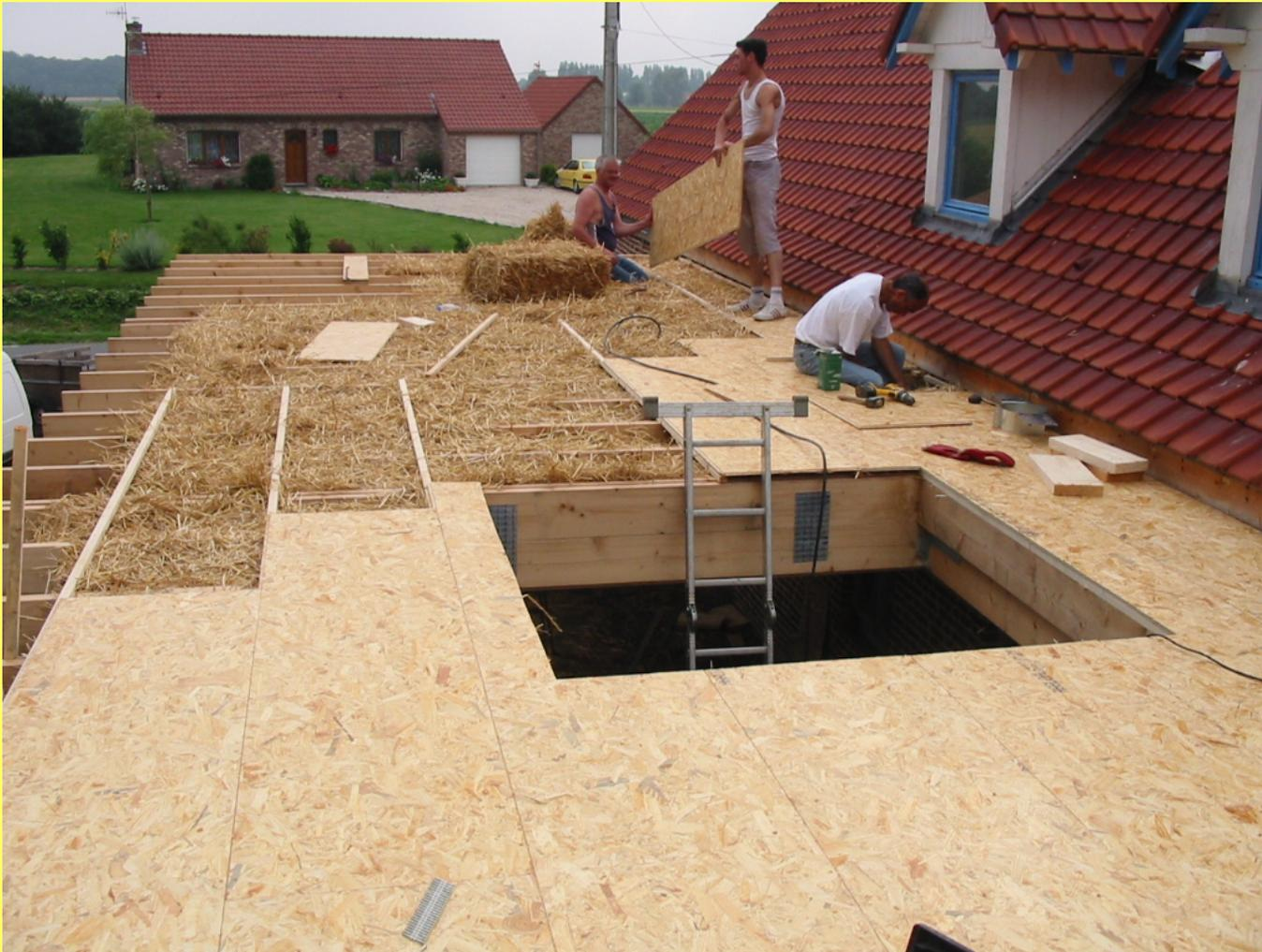
Possibilité d'isolation d'une toiture plate en bottes de paille
